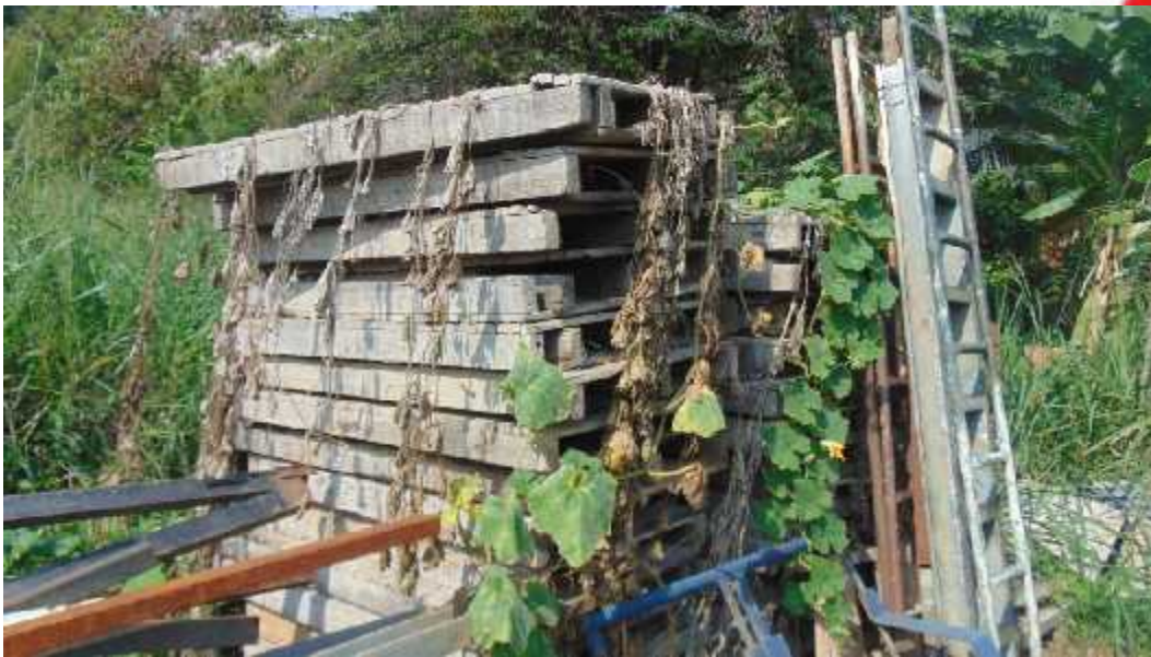
Formaleta y andamios
